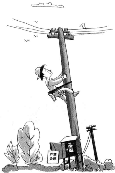
当施工时一定要挂好警示板,以免有人合闸造成触电事故
