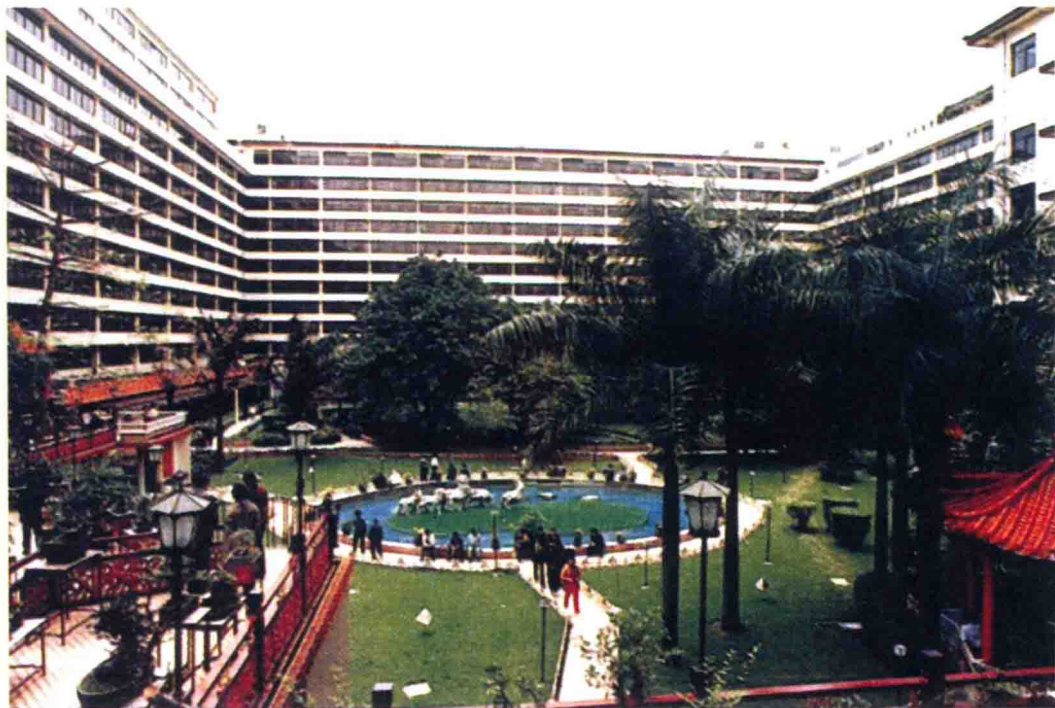
● 1979年6月，广州市东方宾馆向香港上海汇丰银行贷款2200万港元对宾馆进行改造
