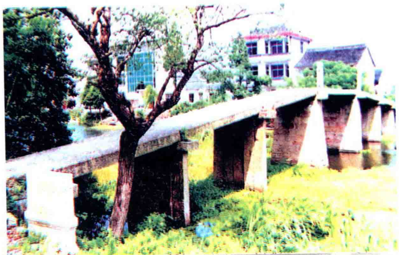
上海金山濟渡橋
