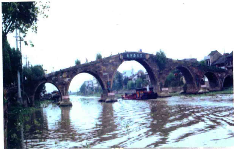
浙江余杭廣濟橋
