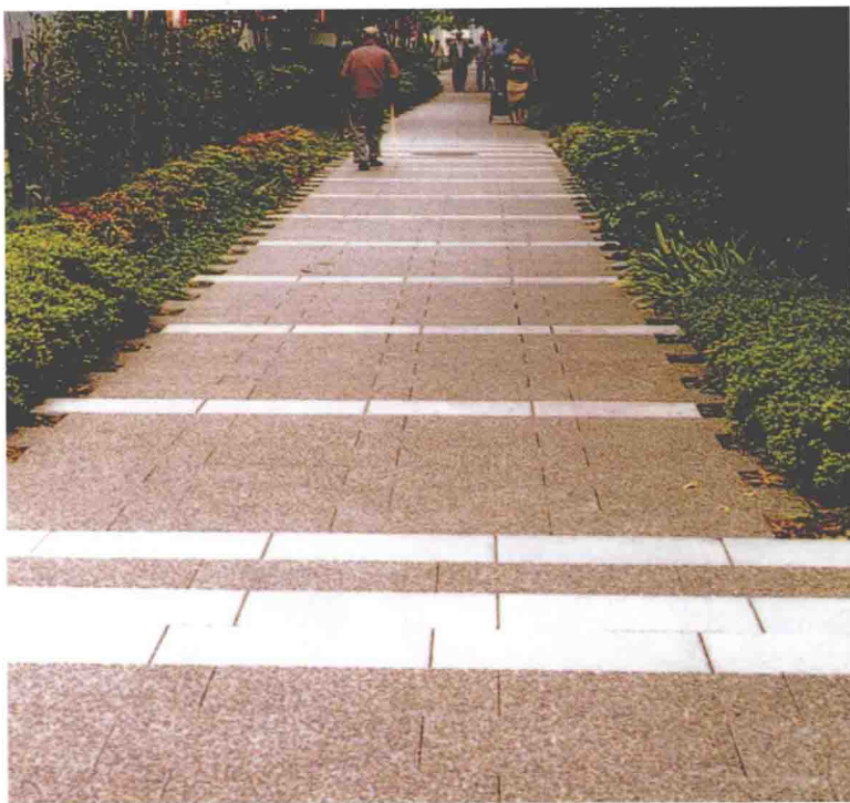
◎ 图 3-11 日本横浜某住宅区前主要供行人与自行车行走的道路,其路沿设计也考虑到紧急情况下机动车的行驶需要。
