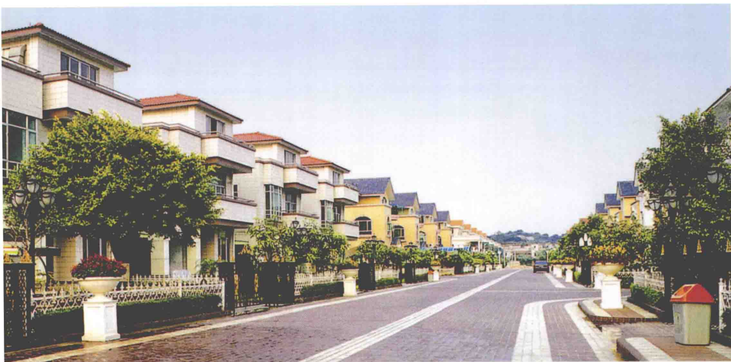
◎ 图3-4 居住区主干道除了常用的混凝土路面外，也可用不同色彩的铺装材料形成富有变化的道路景观。
