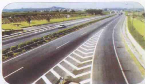
福厦高速公路
