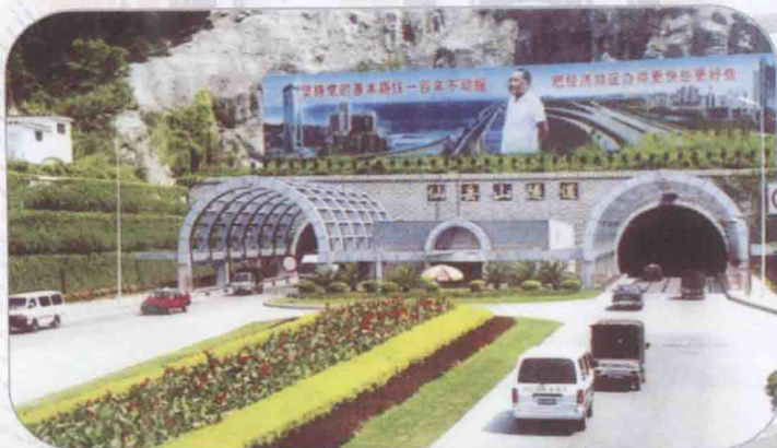
厦门仙岳山隧道
