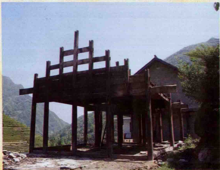
位于采花台村的辛未年贺龙元帅住过的板壁房（拍摄时上盖及板壁已拆损）（季卫民摄）
