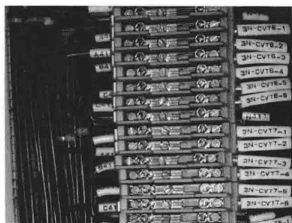
图 1-17 TV 回路遥测端子 2
