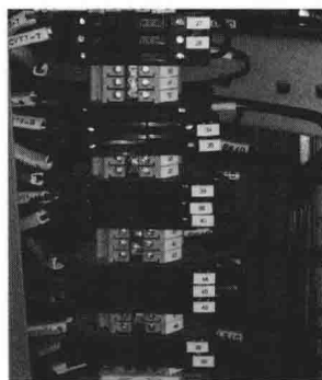
图 1-19 TV 回路遥测端子 2
