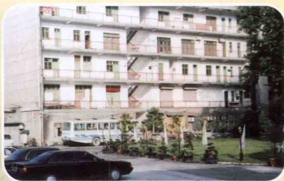
宜昌市群艺馆办公大楼（1994年）
