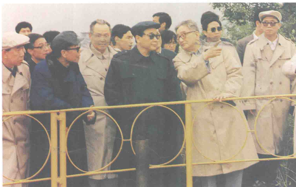
李鵬總理視察長江葛洲壩水利樞紐工程。
