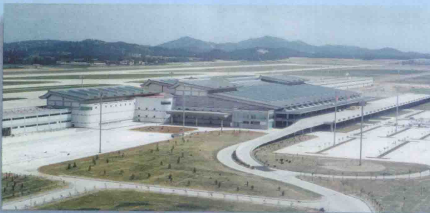
由武夷公司总承包的长乐机场候机楼
