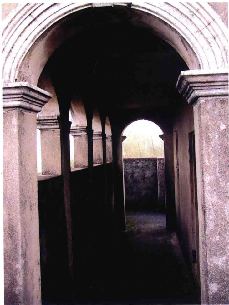
◆塘口镇四九村委会南兴村国兴碉楼柱廊
