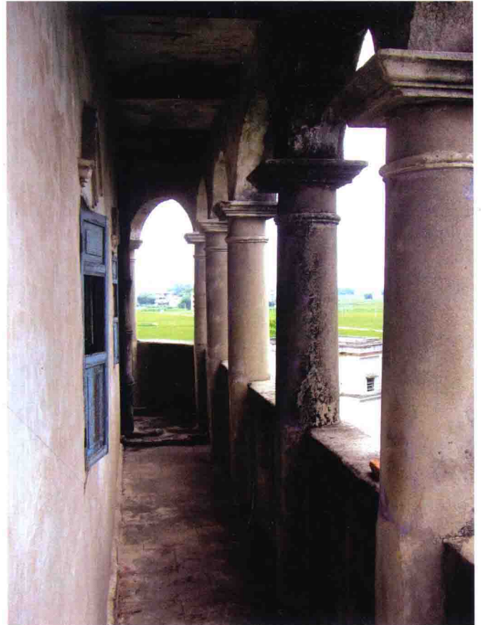
◆ 赤坎镇永坚村委会楼西村养怡楼柱廊
