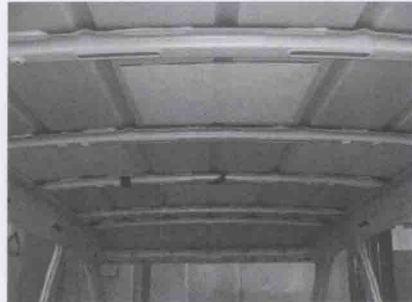
b) 顶棚上的支撑梁
