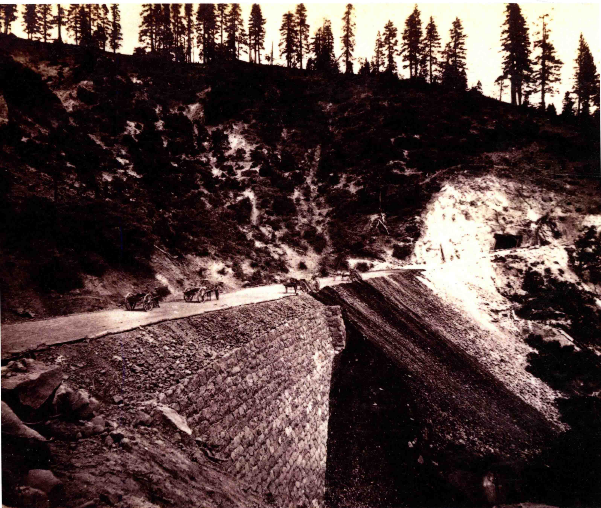
T06 距萨克拉门托 77 英里处野马谷的路基墙（中国墙）及灰熊山隧道，1866 年夏天太平洋铁路就已经建到这里。
