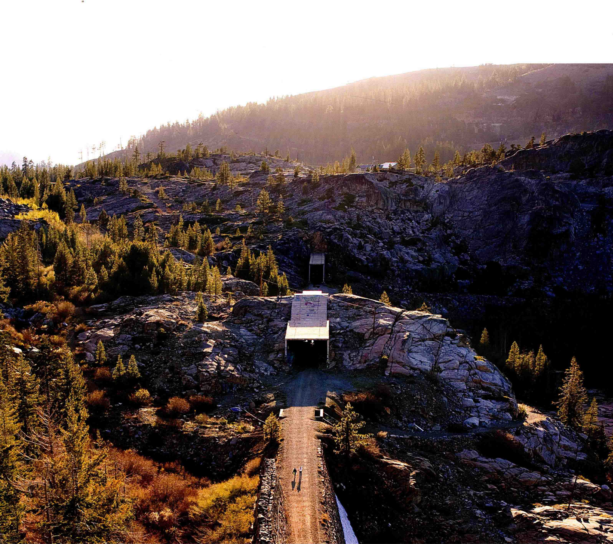
T09 2015 年 5 月 2 日，冒险爬上 8 号隧道西口上的山顶，向西拍摄了 6 号、7 号隧道的全景照片。
