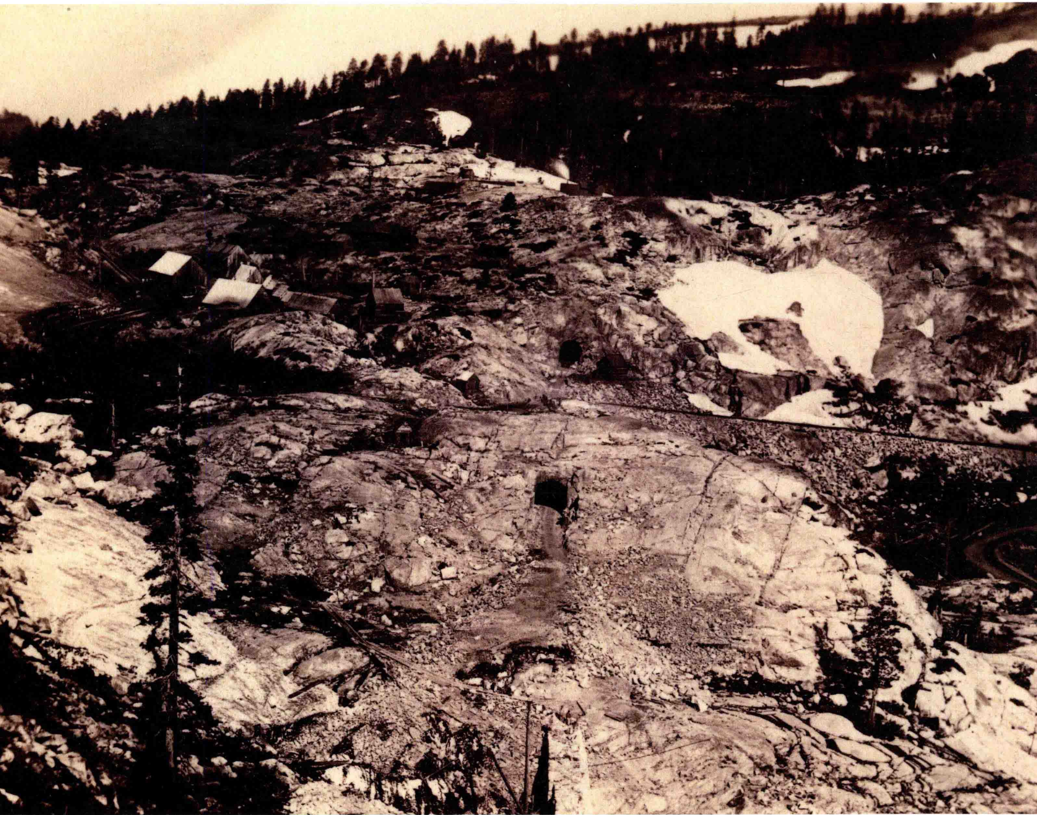
T08 1866 年秋天，在西拉内华达山唐纳关上已下了一场雪，远处竖井上的蒸汽机正在运转，将开挖 6 号隧道（山顶隧道）的石块吊运出来。脚下的一道中国墙——路基墙已经筑好，清晰可见，另一道中国墙——防雪墙还没构筑。
