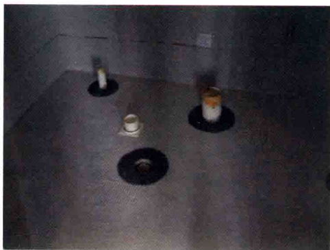
图 1.2.2-2 U-PVC 排水管安装效果图 (二)
