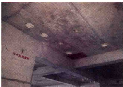
图 1.1.1-1 PVC 管穿楼板预埋 效果图（一）
