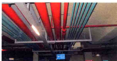
图 1.2.1-2 成排管道安装效果图
