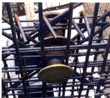
图 1.1.3-2 套管预埋施工图
