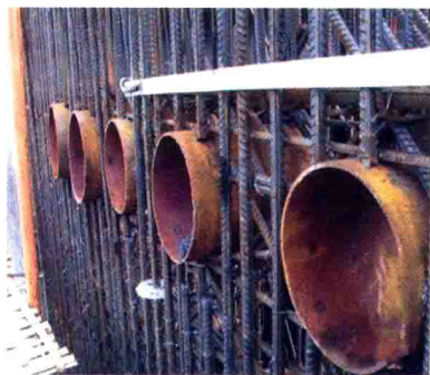
图 1.1.3-2 套管预埋施工图
