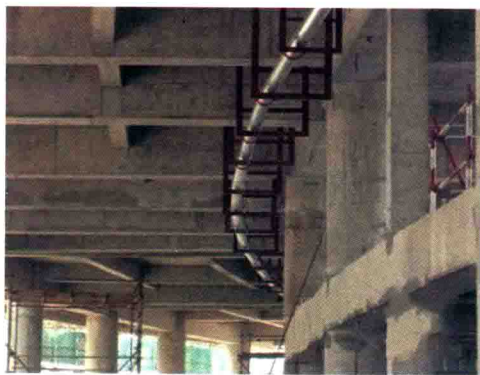
图 1.2.2-3 U-PVC 弧度管道安装效果图
