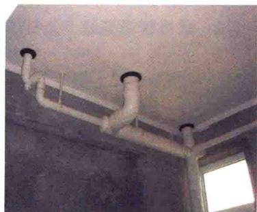
图 1.2.2-1 U-PVC 排水管安装效果图（一）
