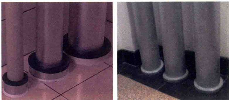
图 1.1.2-3 套管穿楼板效果图
