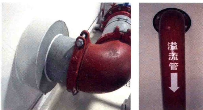
图 1.1.3-3 套管预留预埋效果图
