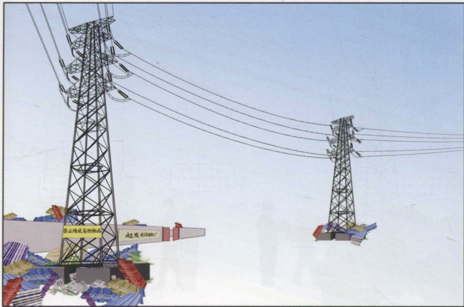
① 电力杆塔下经常被堆放易燃物品
