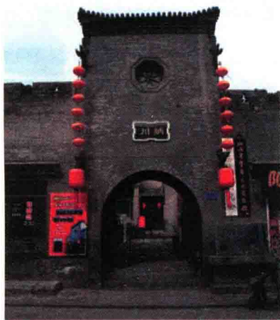
图1-3 雄踞县城东大街的渠家大院
