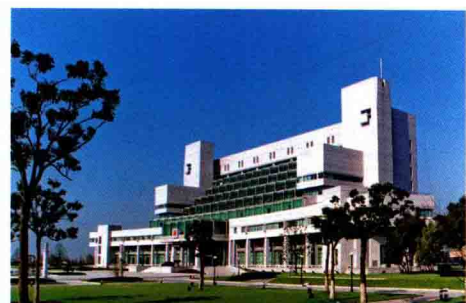
上海金山区政府办公楼 Shanghai Jinshan District Government Office Building 中国 上海, 2000年
