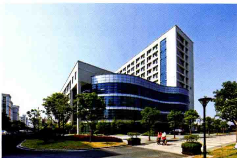
浙江商业职业技术学院二期 Zhejiang Business College, Phase II 中国 杭州, 2010年
