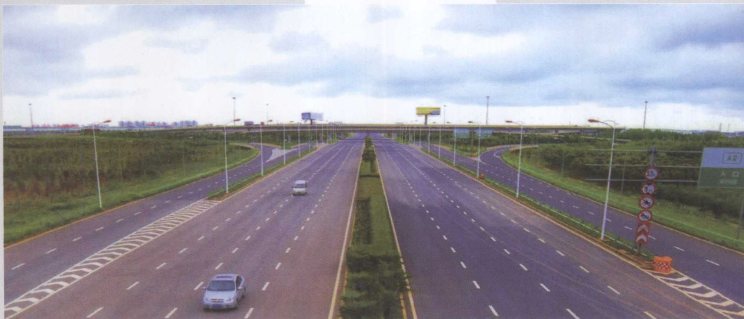
S2 (A2、沪芦) 高速公路
