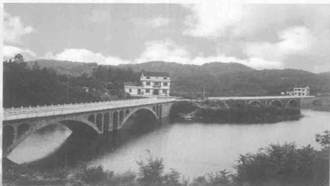
高坝洲库区新建的公路桥
