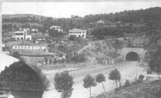
麻岭坳公路隧道外景
