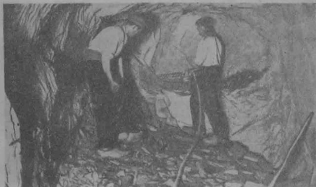
(鑛石之採掘)(其四) 圖中用鑿巖機鑽孔以代手掘，利用壓縮空氣以轉動該機，此法或用以採掘鑛石或用以開鑿坑道。
