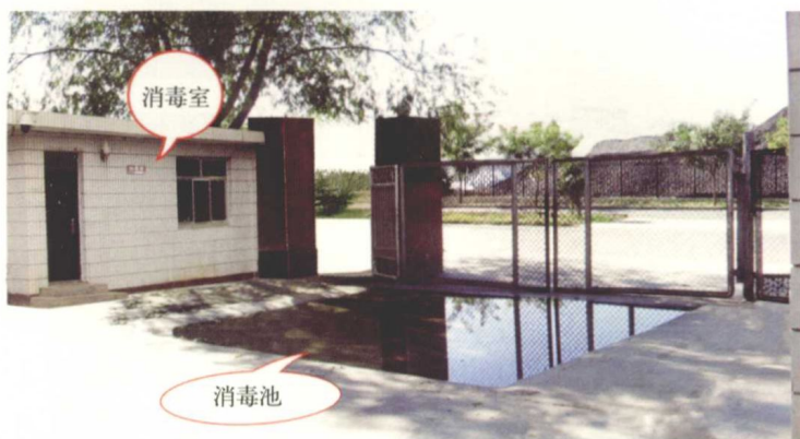
图1-3 主大门、消毒室和消毒池
