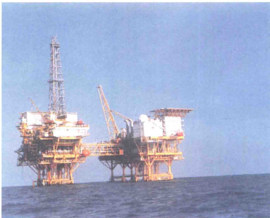
● 20世纪90年代建成投产的中国海洋石油总公司 南海气田开发海上平台
