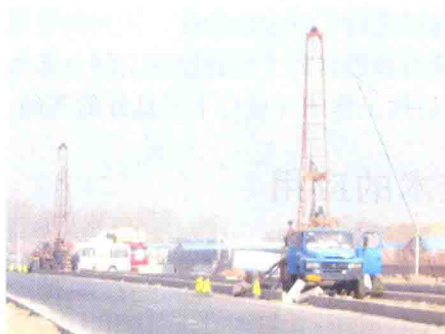
图 1-1-2 DPP100 型钻机钻探现场
