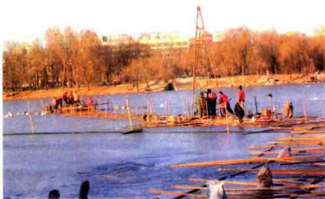
图 1-1-4 玉渊潭东湖水上钻探现场
