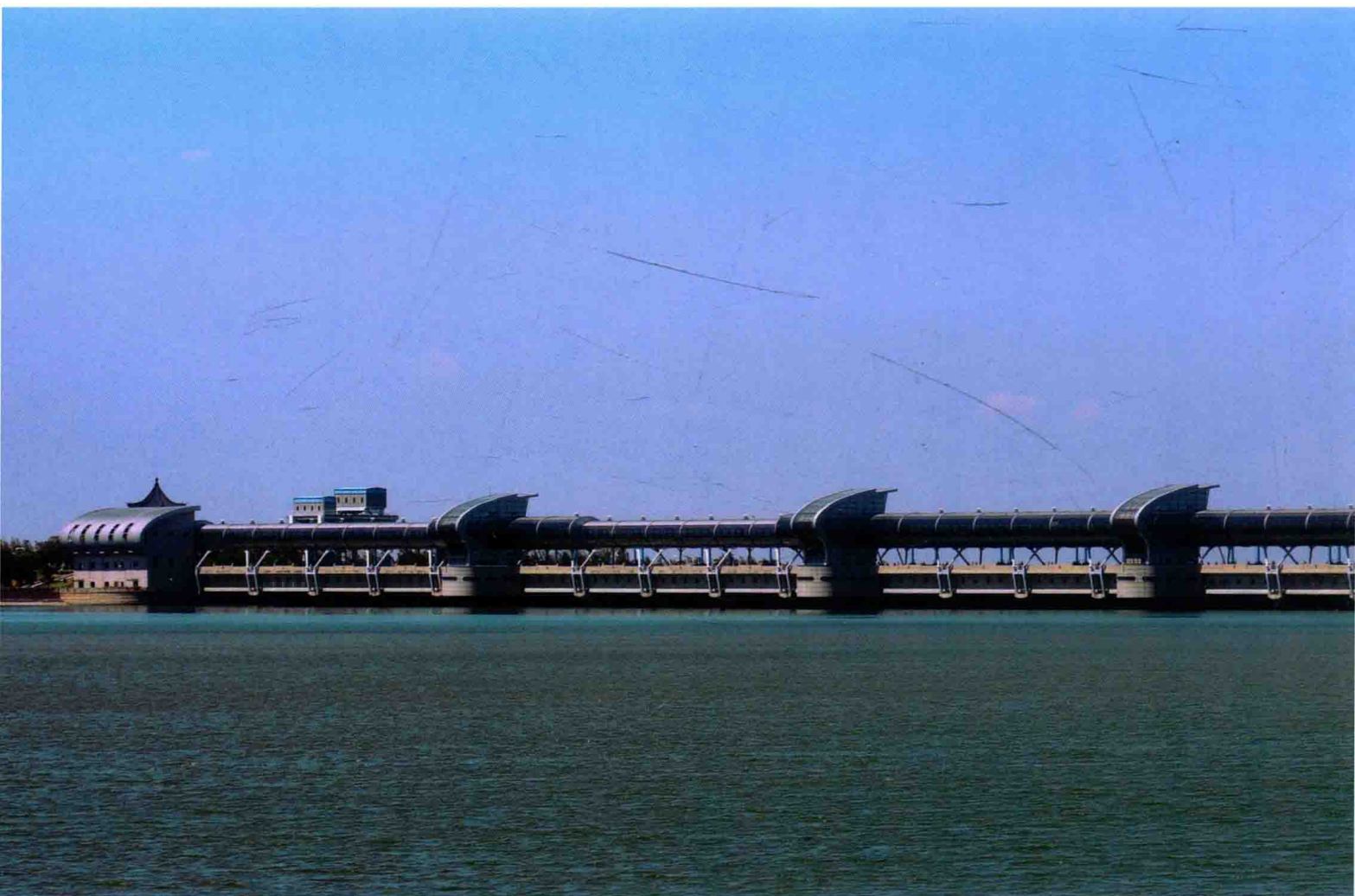
浙东运河段 浙东运河西起杭州西兴镇，经萧山、绍兴、上虞、余姚到宁波连至出海口。浙东运河建成早、保存相对完整，至今发挥着水运、灌溉、蓄水、防洪、防潮等重要作用。图中的曹娥江大闸水利枢纽工程距离绍兴市30千米，主要由挡潮泄洪闸、堵坝、导流堤、连接坝段及管理区等组成。大闸于2007年完工，实现了导流、排洪、揽潮和鱼道控制等综合功能，是国家重点工程，也是中国水利工程史上一个成功的范例
