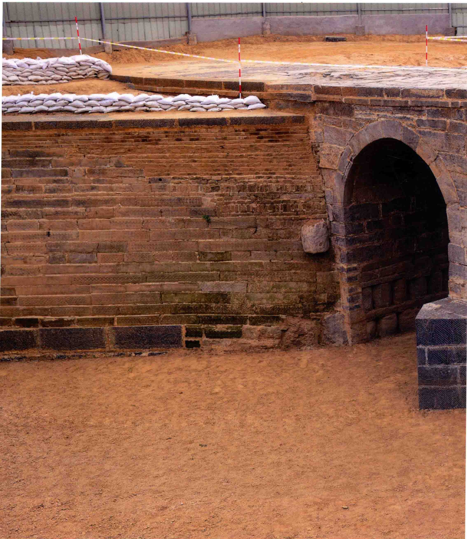
通济渠段 通济渠从洛阳开封经郑州、商丘、淮北到江苏北部，是隋唐及宋代的漕运要道，元朝京杭大运河南北段通航后逐渐废止。图中郑州市东部古汴河上的惠济桥遗迹是隋唐运河上重要的水利枢纽，是古代运河技术的精华，也是运河、黄河及黄河灾害的例证
