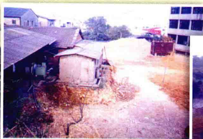
拆除中工廠之一隅
