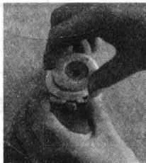
①准备好熔断器, 并将上瓷盖用手旋下
