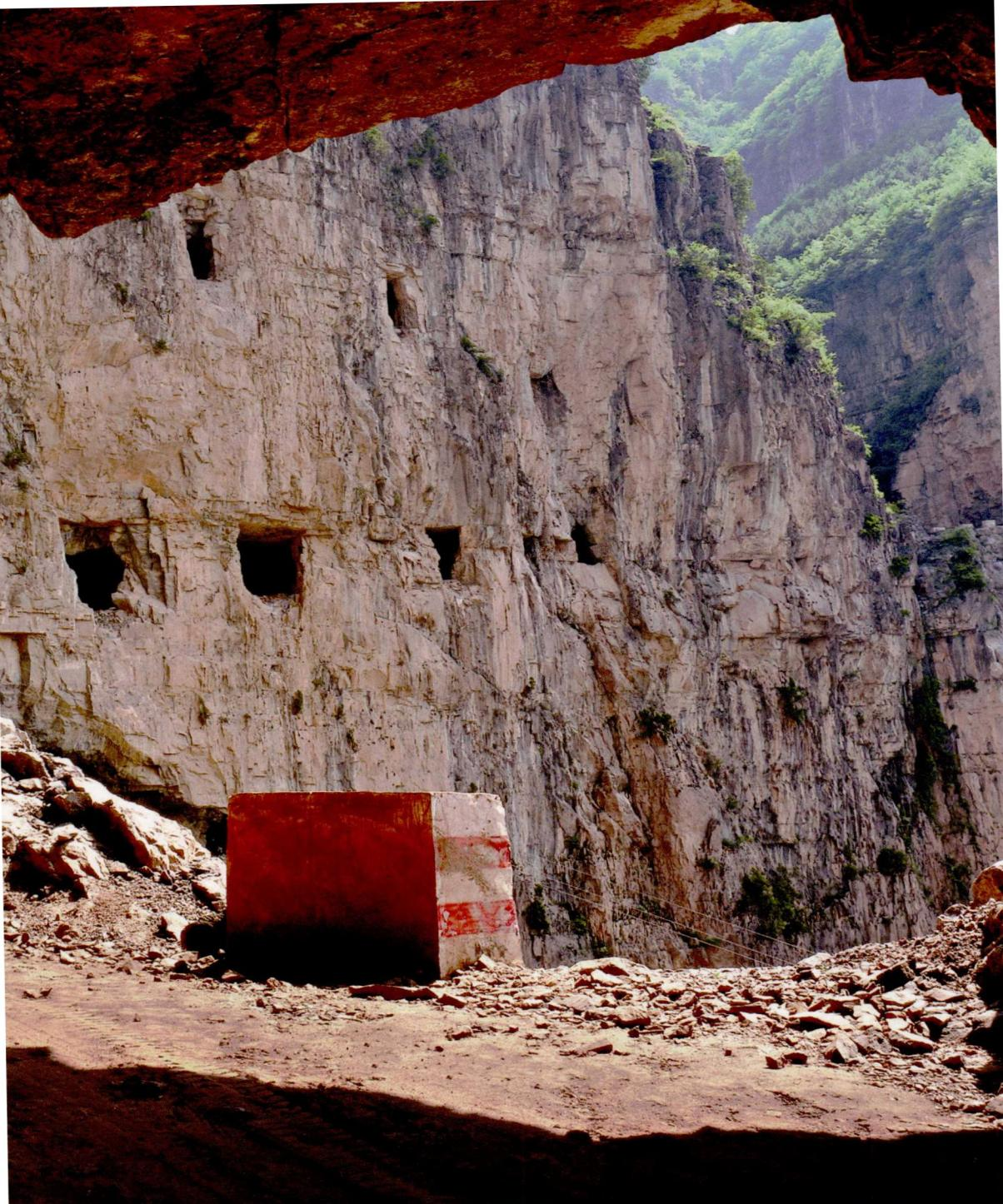
太行山的挂壁公路最能体现太行人性格和太行人精神，这是锡崖沟挂壁公路的一段，它开凿于南太行山体上部的灰色石灰岩长崖中。看似无法逾越的绝壁，却并未让人绝望，硬是在崖壁中开凿出了攀山的隧洞，隧洞一侧的窗洞，在崖壁上显现出了挂壁公路曲折的轨迹，参差不平的洞壁，留存了开路人的粗犷、艰辛与勇气。
