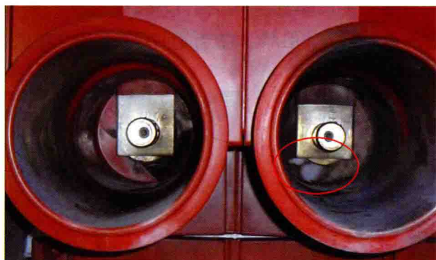
图 2-3 B 相上触头盒内铜母线排端部 对触头盒底部放电
