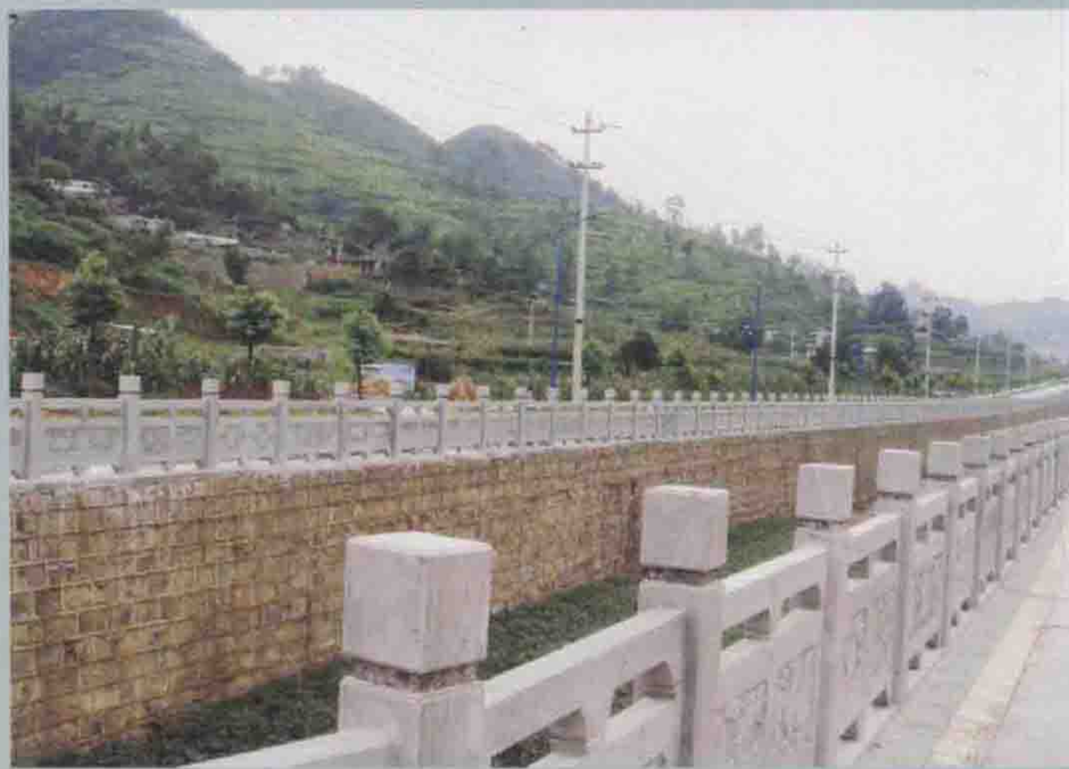
县城东升大道河堤护栏 (2009年摄)
