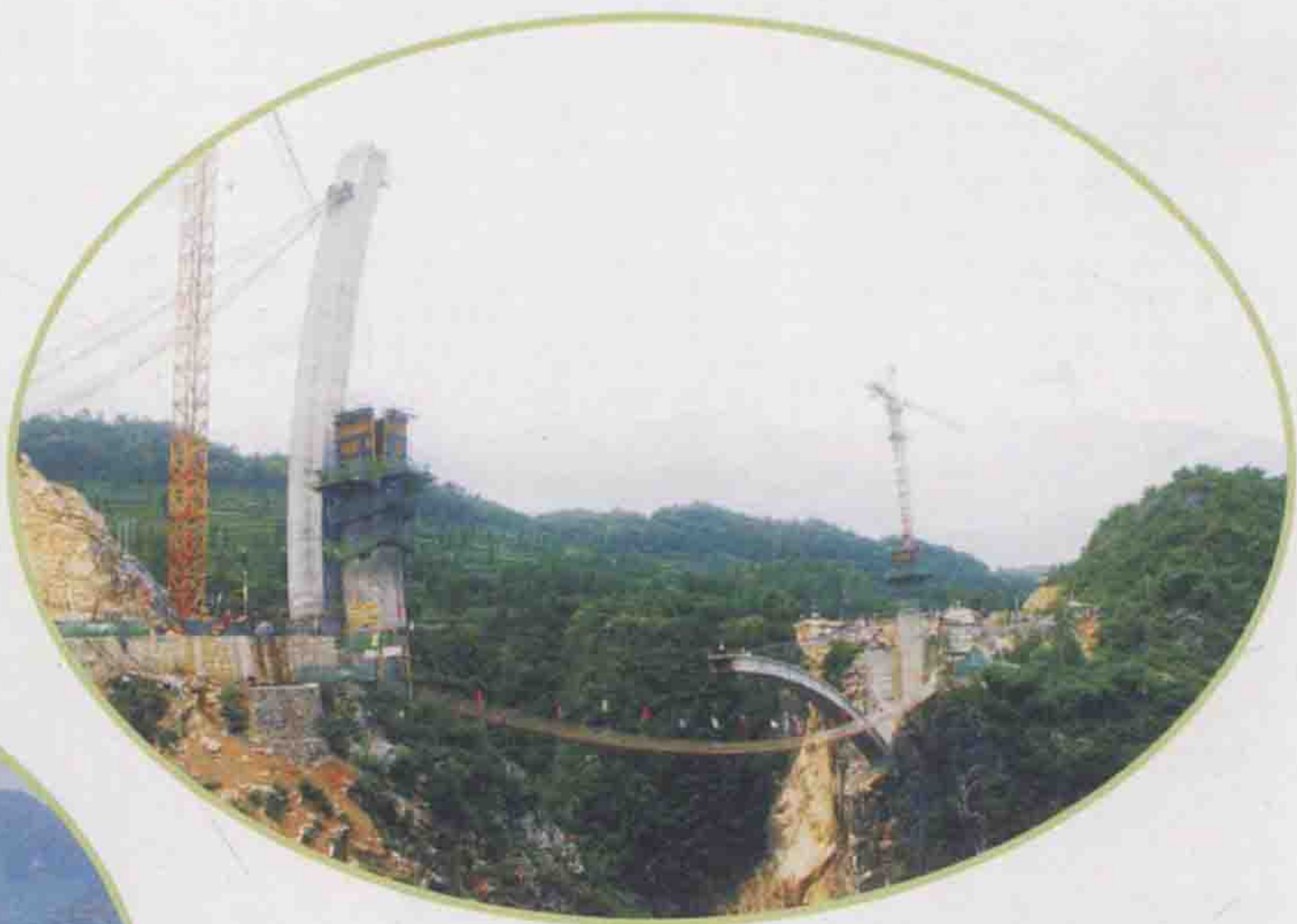
建设中的珍珠大桥（2007年摄）
