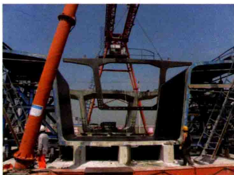
图9 端模安装
