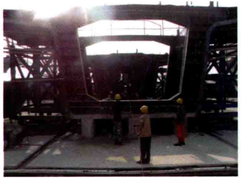
(b) 内模拆除 2
