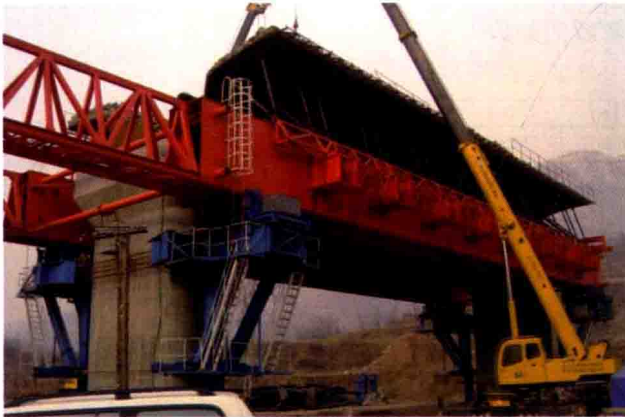
图 2 移动支架法施工箱梁
