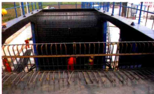
图 15 钢筋绑扎卡具
