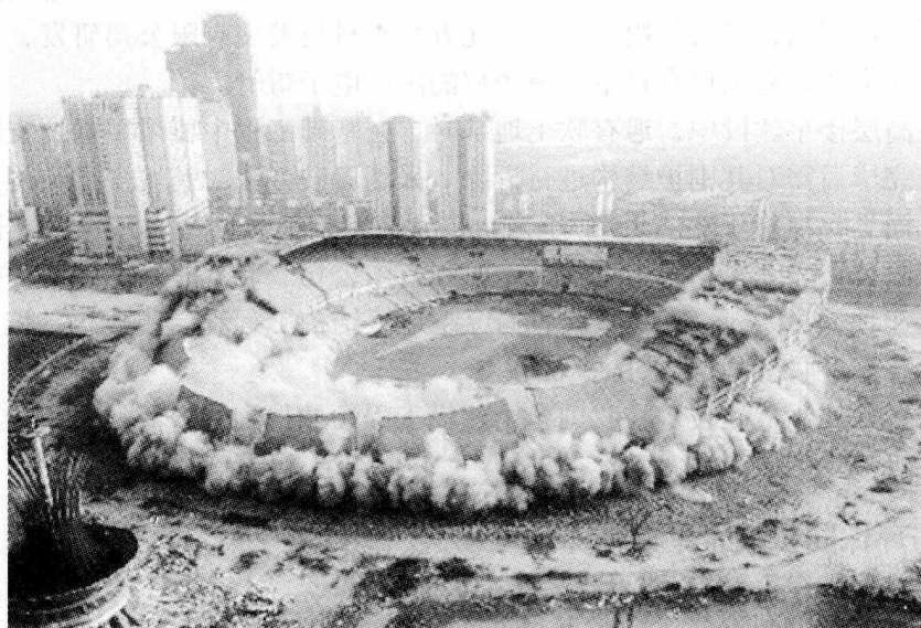
图2 五里河体育场爆破瞬间 (广东宏大爆破股份有限公司, 2007)
