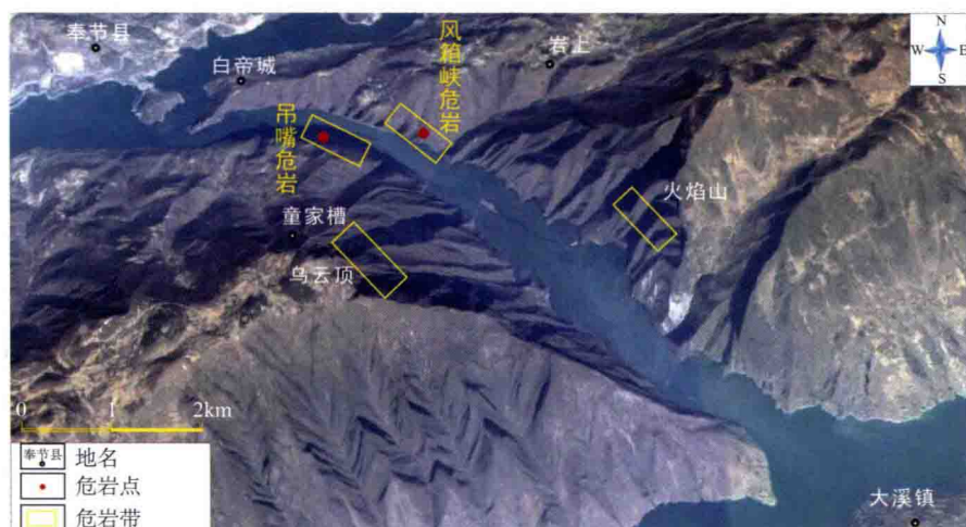
图 1.5 瞿塘峡高陡岸坡发育及重要危岩体分布
