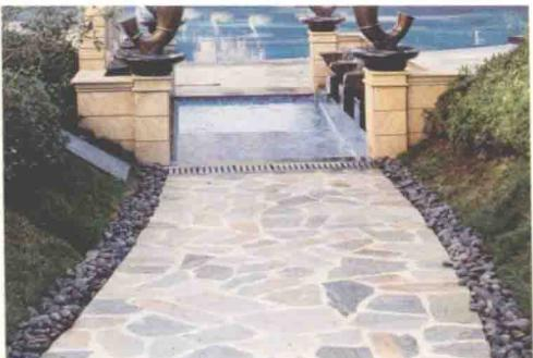
石材作为地面铺装应用很广，从室内到室外、从广场到街道，石材地板都占有一席之地。一般石头是以块石、卵石、碎石等形式被利用的。块石主要运用在较大面积的路面，较平整。卵石可以松散地铺在地面上，或嵌在水泥沙浆里，它铺装的表面是高低不平的，但却很有质感。碎石多用于填补路基，由于没有一定的几何外形，利用比较灵活。铺装的石材种类不同，所带来的装饰效果也往往大相径庭。大理石颜色众多、花纹独特，石材表面有闪亮的光泽，非常吸引人的眼球，并给人一种高贵典雅的感觉。花岗岩是所有石材中最坚硬、最持久耐用的材料，它抗染色和抗污能力很强，有多种风格和样式，且极具审美感。板岩独特的纹理和颜色给人温暖而踏实的感觉，有一种独特的视觉冲击感。石灰石是非常古老的铺装材料，它带给人的是一种古朴干，富有韵味。
