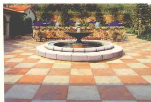
砖是一种非常普遍的铺地材料，它们能与天然石材或人造材料很好地结合起来，能为植物作很好的陪衬，能够拼成很多或简单或复杂的图案。砖的颜色有很多种，要根据周围建筑的色调进行恰当选择。值得一提的是，粘土做成的铺路砖比建筑用砖有更多的形状和图纹，它们有多种颜色和质地，且最适于装饰路面。砖一般分为混凝土砖、瓷砖、青石砖、岩土砖等。混凝土砖主要采用水泥、砂石等普通混凝土材料做成，尺寸规整，抗冻性能好，有利于砌体平整度的控制，施工适应性能强。瓷砖具有一定的耐磨性，用素烧粘土制成的瓷砖最硬，很难切断，适合用在正方形的地方。瓷砖也可以在砂浆层上拼砌。彩陶瓷砖最具装饰性，但也最易碎。青石砖有独特的色样，耐用又好看，适合于园林、庭院等优雅环境的铺地。岩土砖具有吸水排湿功能，下雨时，既能够迅速透水，又能够防滑。
