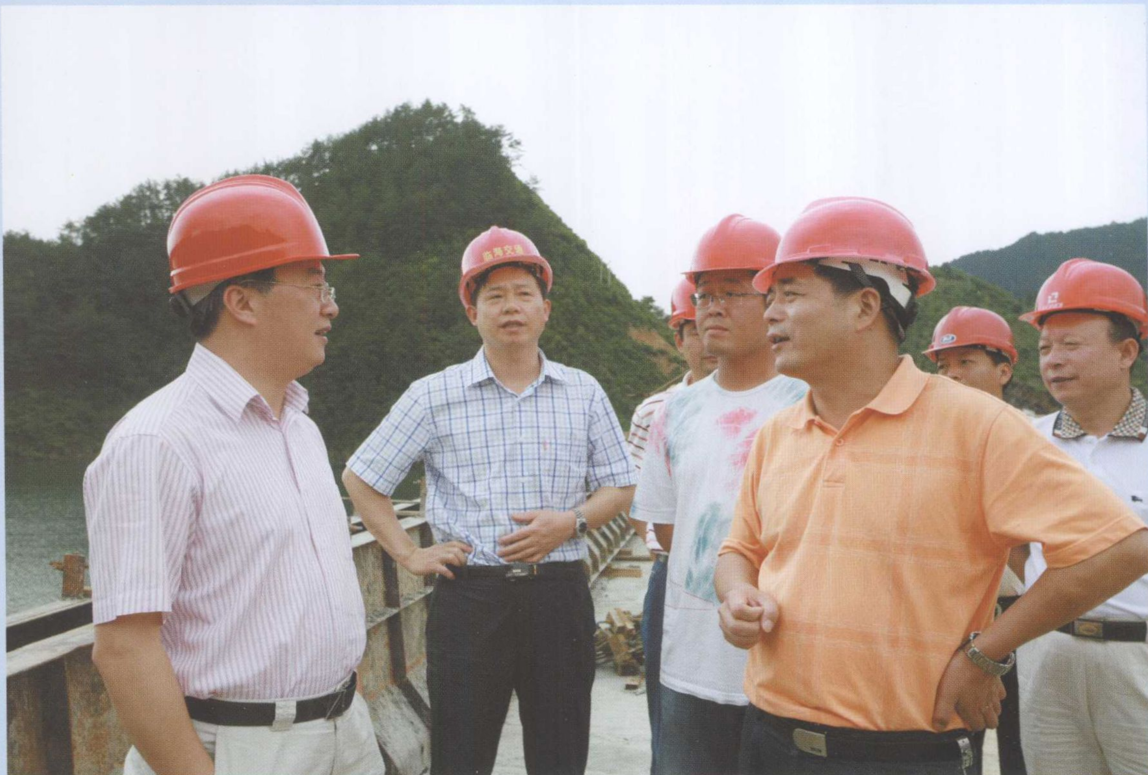
2007年10月，县委书记陈新华检查指导交通建设工程
