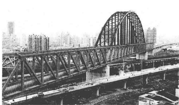
图1-13 合肥经开区特大铁路桥
