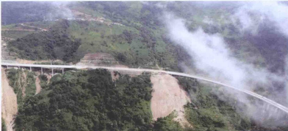
图 1.2 山区长下坡路段高速公路
