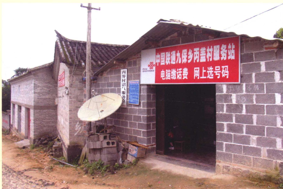
图 26 丙盖村沼气服务站兼中国联通服务站
