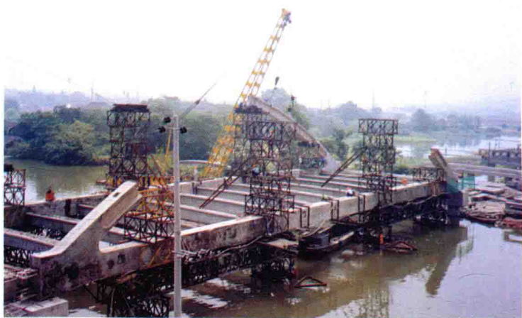
施 工 中 的 茅 安 前 大 桥
