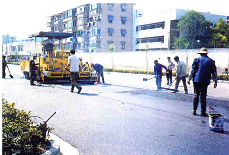
施 工 中 的 茗 溪 路
