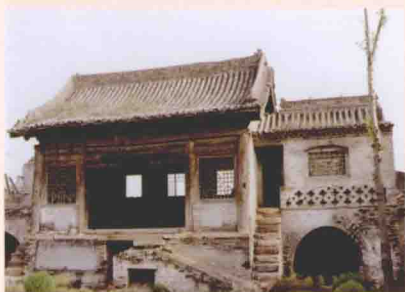
山西离石石盘村圣母庙山门舞楼 (维修前) (陈美青提供)
