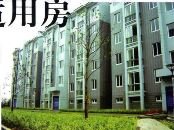
图1-1 某城市经济适用房外观
