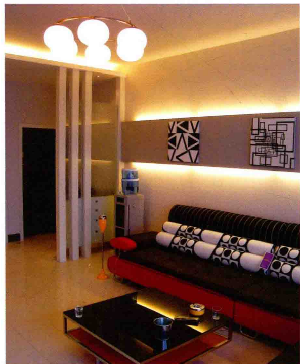
图1-6 局部吊顶与舍弃顶角线的完美结合
