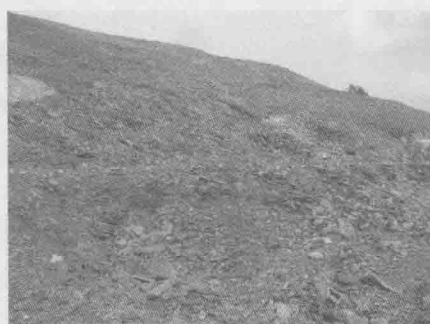
图 1 边坡破碎岩体
