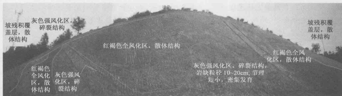
图 2 边坡岩体结构分区图
