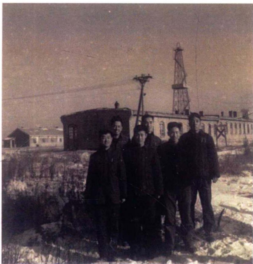
大庆第一口检查井（3-22#）现场 摄于1964年
