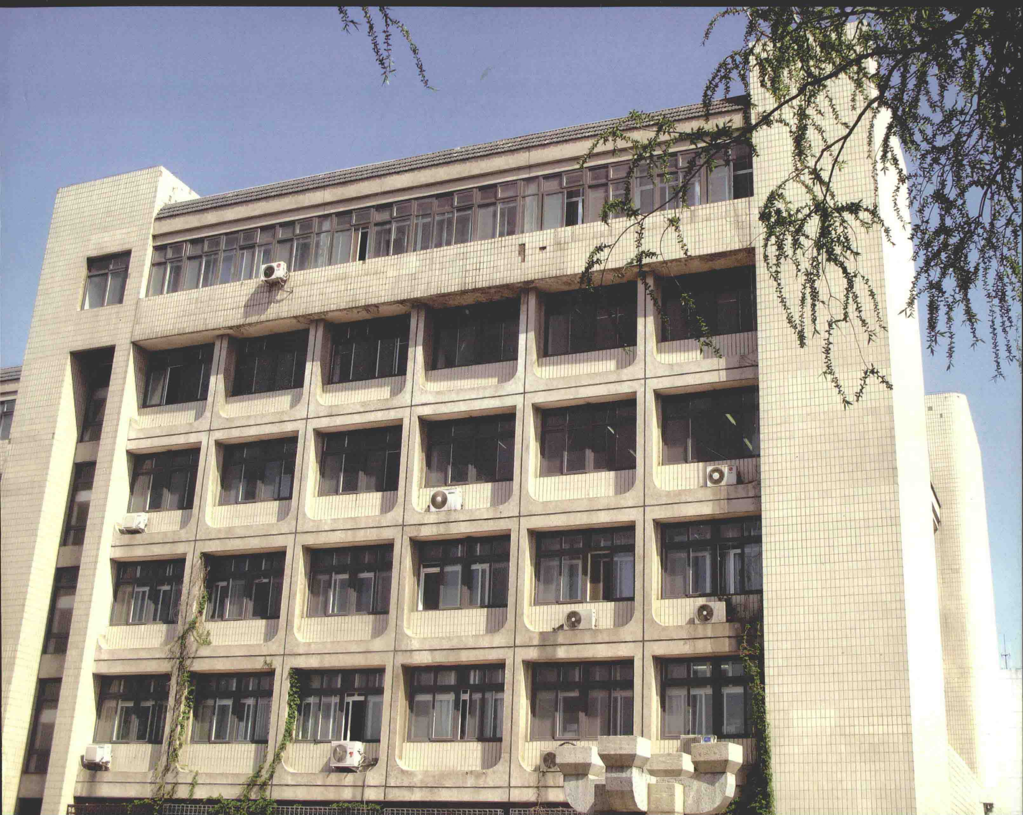
建筑系馆局部
