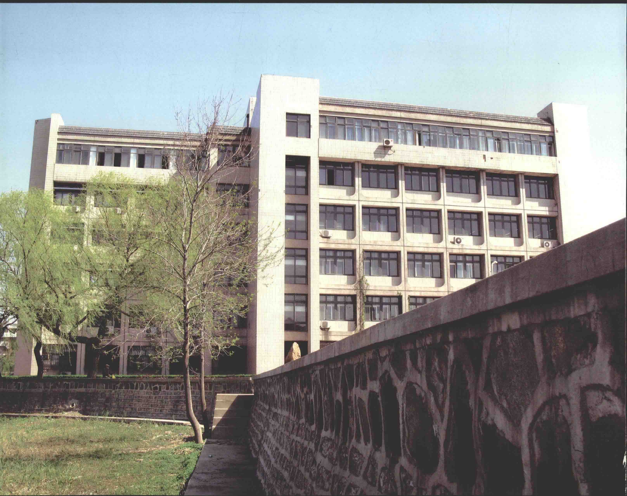
建筑系馆的南立面
