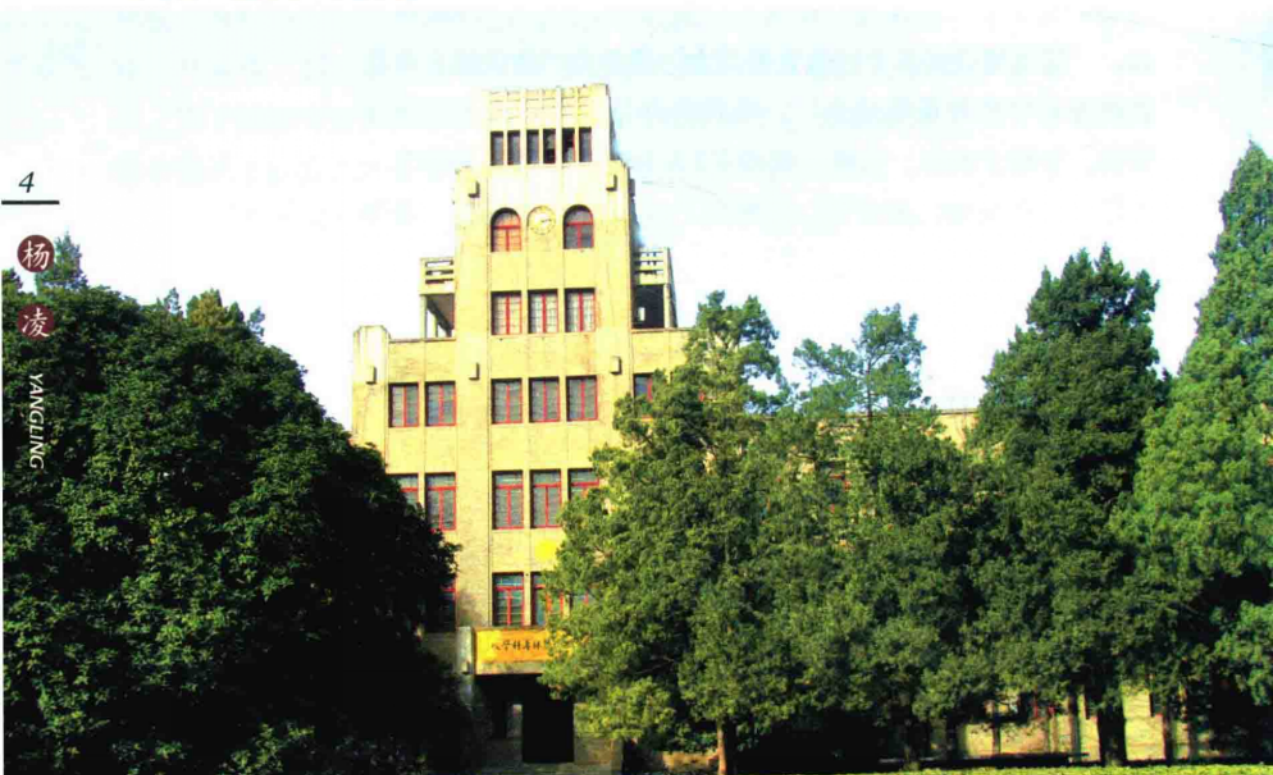
西北农林科技大学三号教学楼
