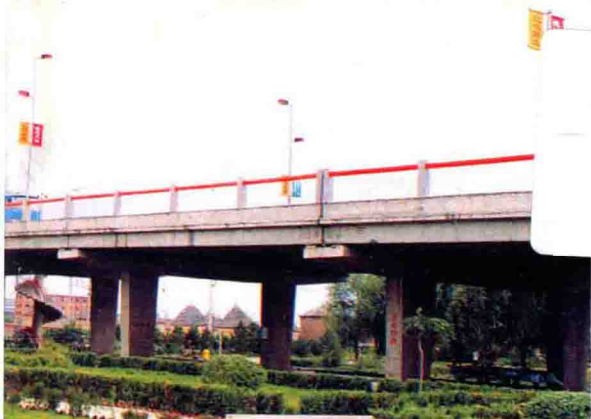
横跨哈大铁路干线的德惠城南公路立交桥
