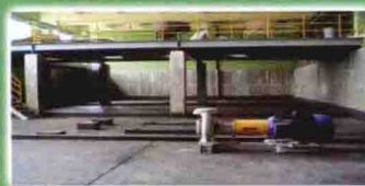
■ 浇灌整体呋喃混凝土地面
