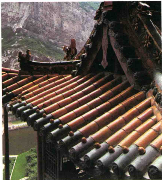
恒山寺庙的屋顶
