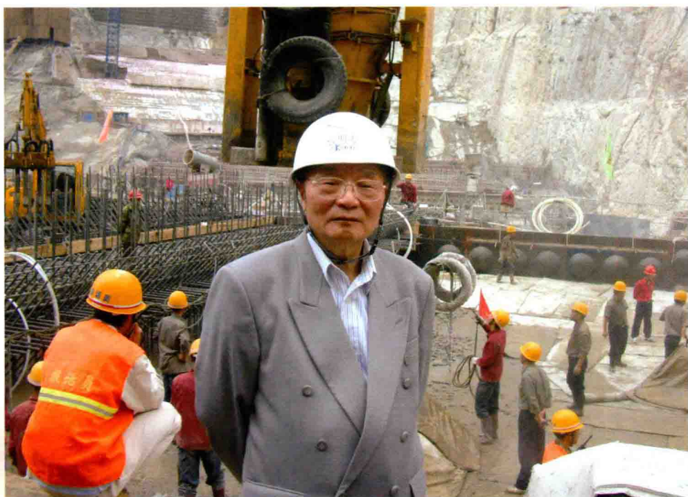
2006年4月，在小湾水电站坝基浇筑仓面
