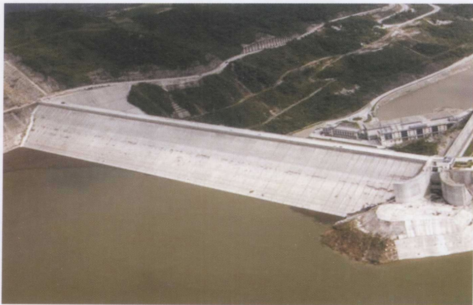
图 1.1 紫坪铺水利枢纽工程
