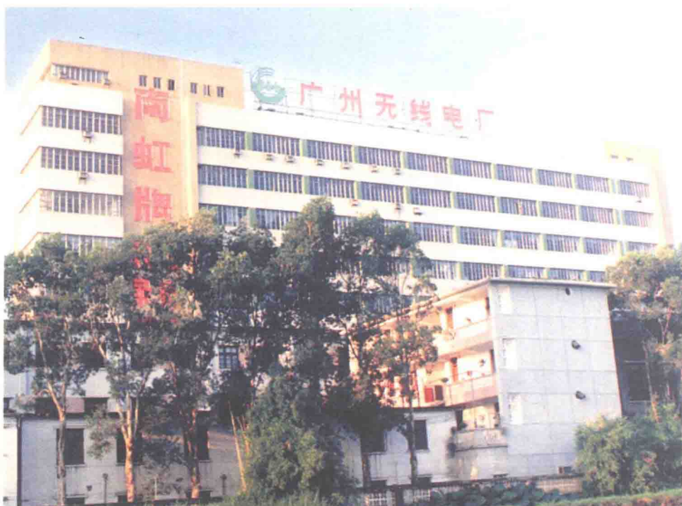
●90年代，广州无线电厂无线电通信设备生产厂房
